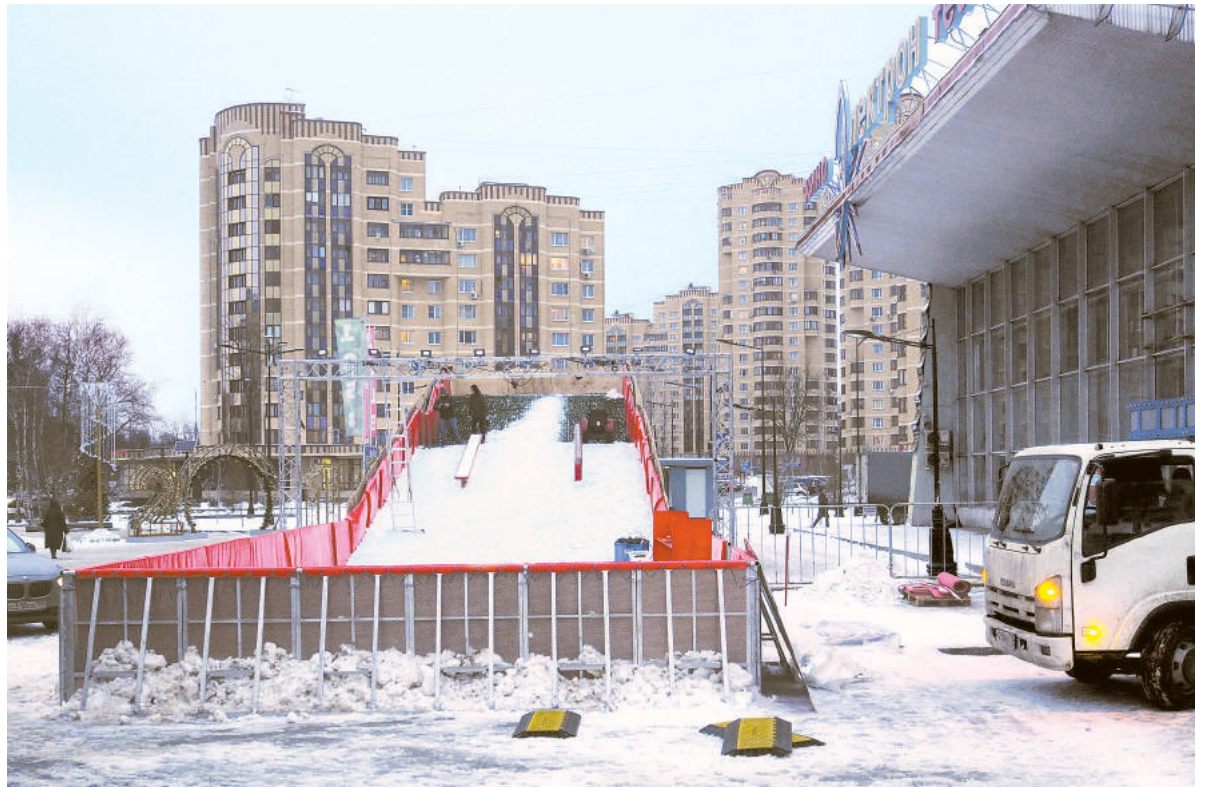
На площади Юности началась установка 35-метровой горки.
