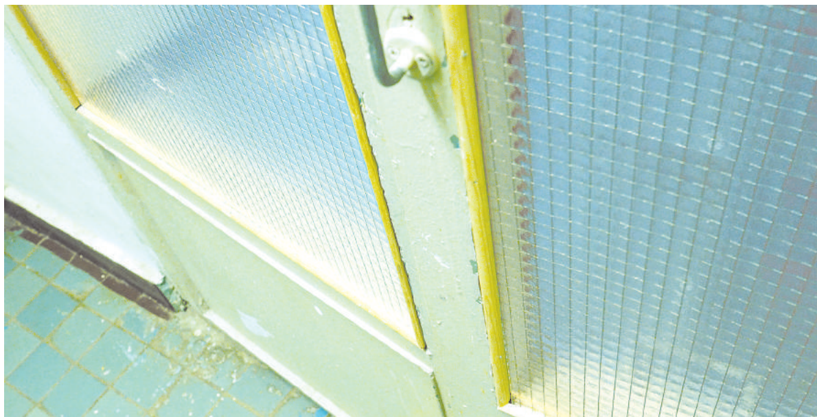
Наличники дверей восстановлены, разбитые прозрачные панели заменены.
