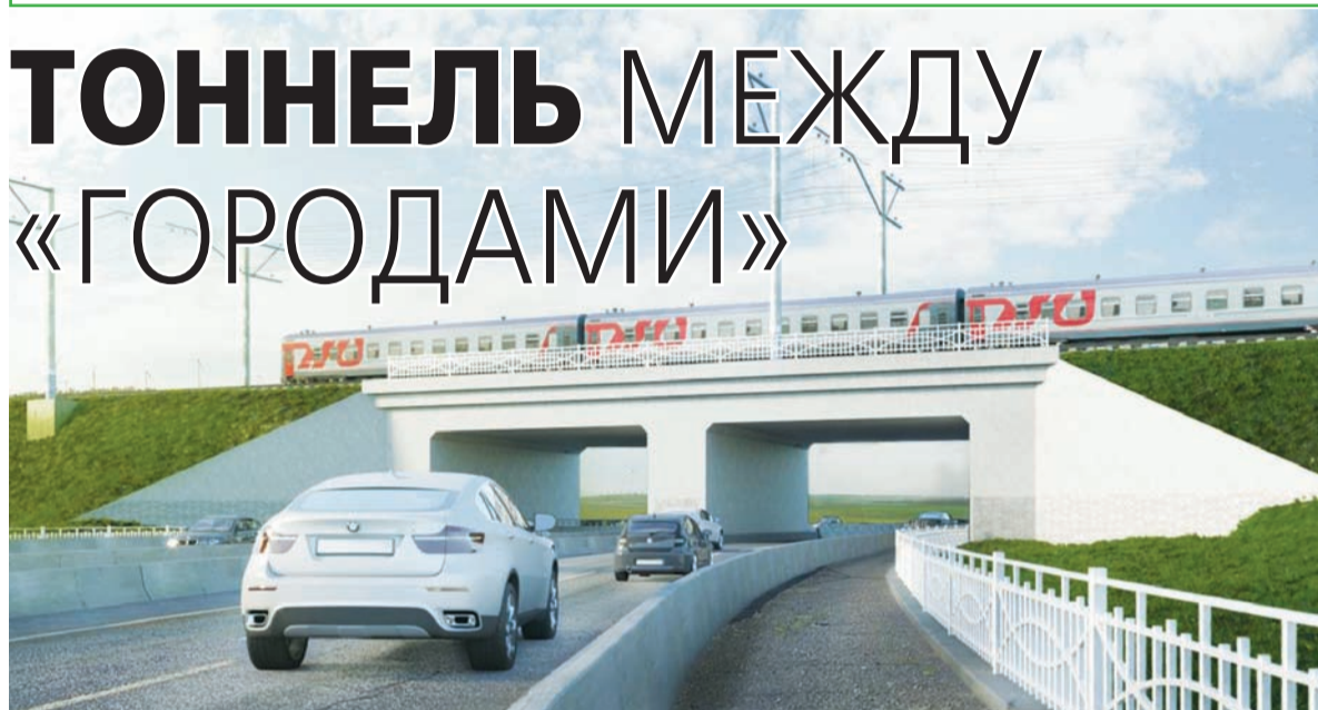
■ Третий путепровод через железную дорогу пройдет в районе Алабушево
