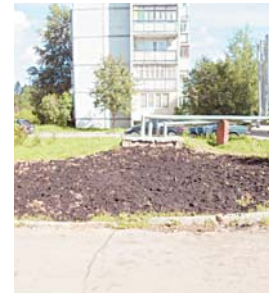
Теплосети Алабушево в.ч. д. 12
