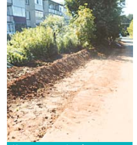
Канализация Алабушево трасса Линейная 2
