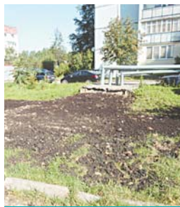
Теплосети Алабушево в/ч
