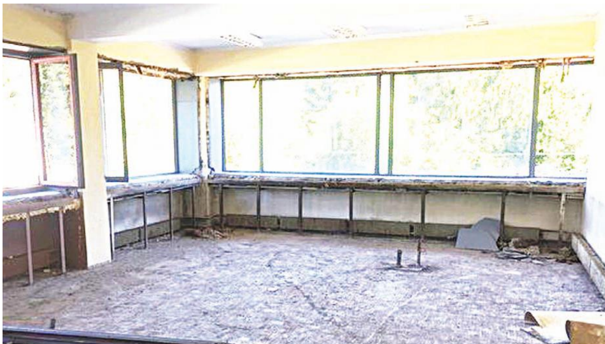
В ходе ремонта в здании учреждения культуры планировалось реконструировать крышу, фасады, систему отопления, электрику и канализацию.
