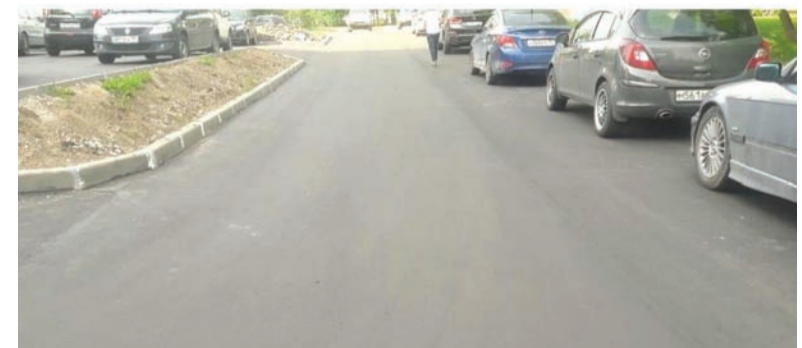
Нарушения устраняются балансодержателями территорий, управами и ГБУ «Жилищник» районов
