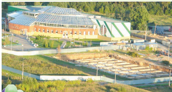
Строительство регбийного стадиона
