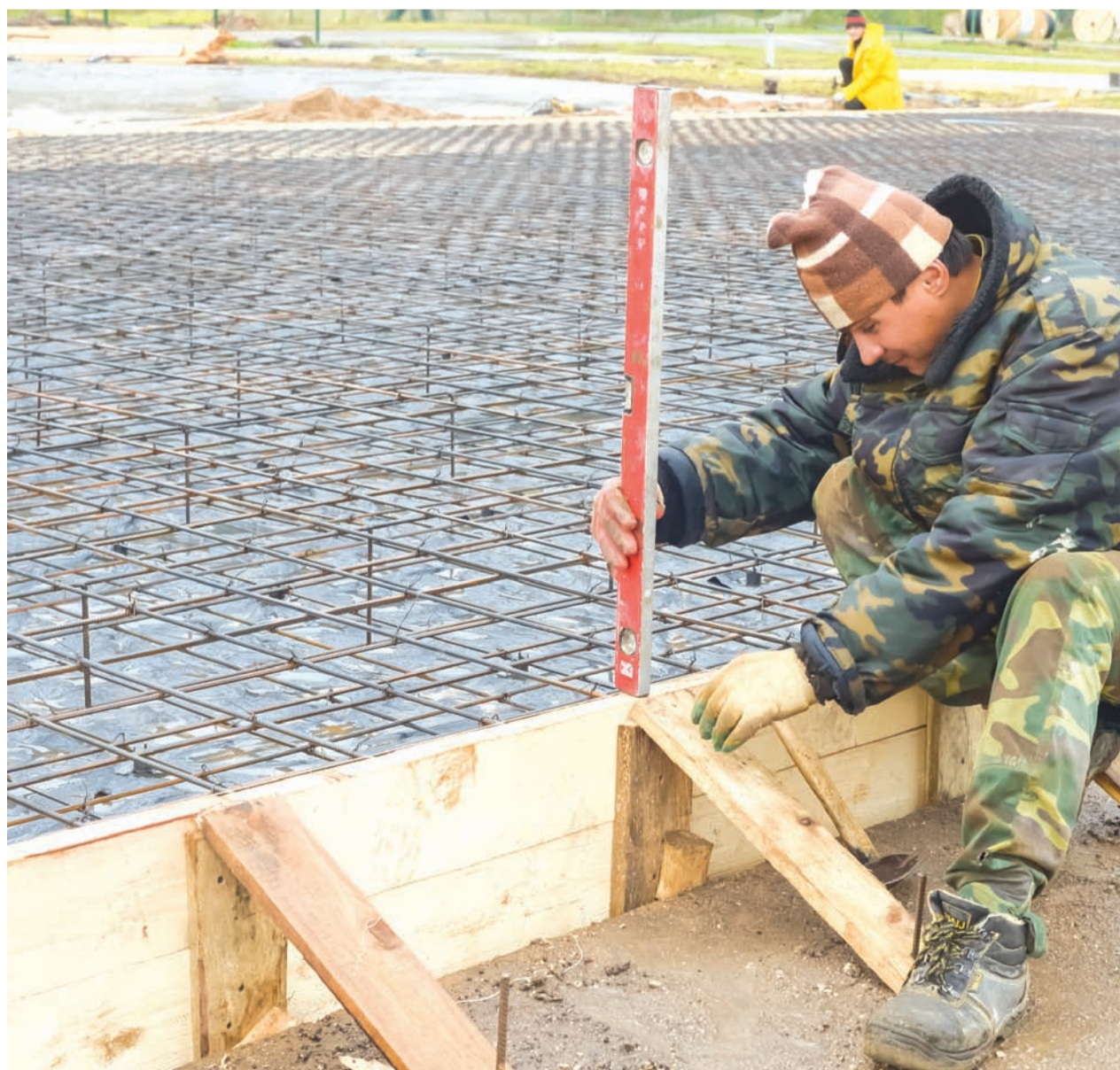
Идет укладка основания под технические боксы
