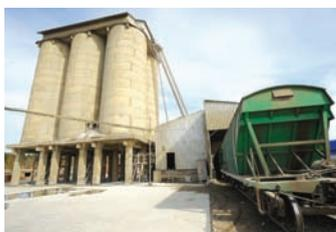
Железнодорожный терминал с высоким путем и фронтом выгрузки 12 вагонов и площадкой открытого хранения на 30 000 куб. м для приема и перевалки щебня полувагонами
