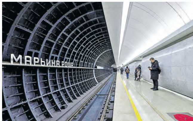
Изыюминка станции «Марьяна Роща» – открытые конструкции каркаса туннеля
