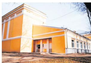
Масштабная реконструкция Дома культуры «Выстрел» началась в прошлом году и была разделена на два этапа. На первом этапе заменены оконные блоки, отремонтирован фасад, установлены новые системы электро- и водоснабжения, завершены кровельные работы. Также смонтированы системы отопления и вентиляции.
