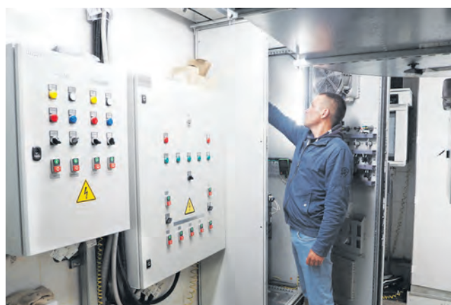
Насосная – техническое помещение под землей около фонтана в парке 40-летия Победы
