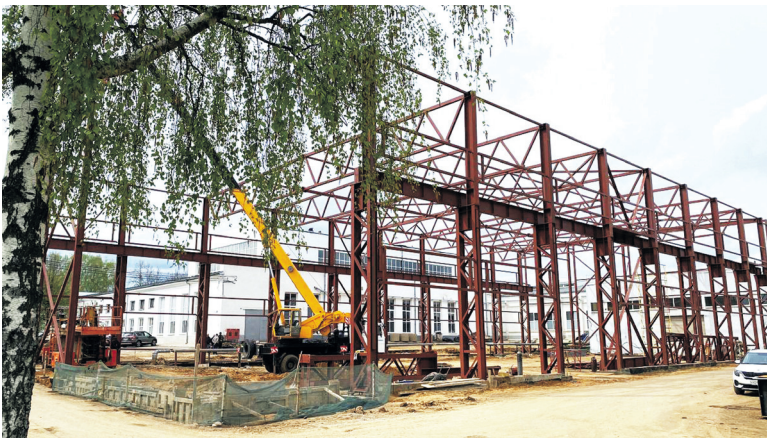
Строительство нового цеха
