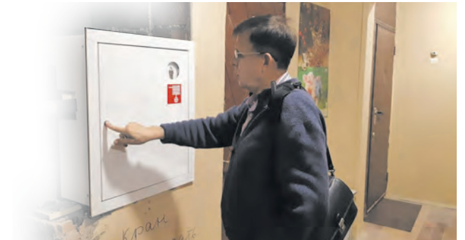
Проверка противопожарного оборудования в подъезде
